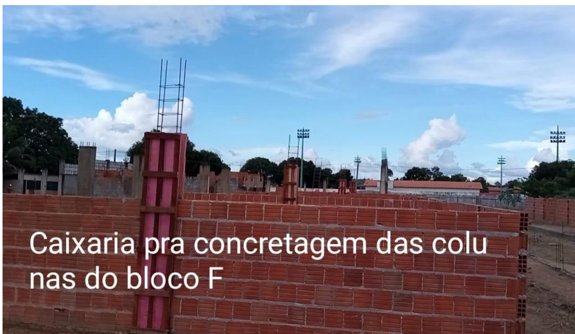
Alvenaria dos Blocos E e F
