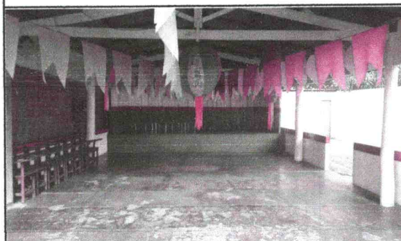
PARTE INTERNA - GALPÃO EM MADEIRA E TELHA BRASILIT - PISO
