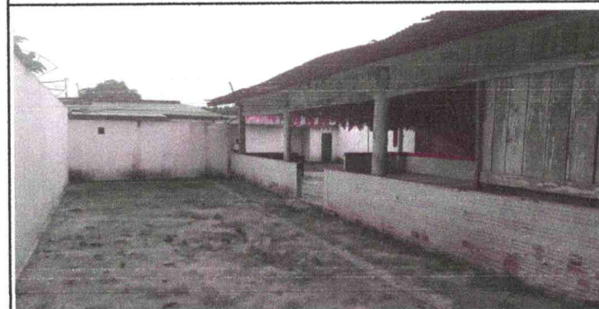
PARTE INTERNA - GALPÃO EM MADEIRA E TELHA BRASILIT - FUNDOS
