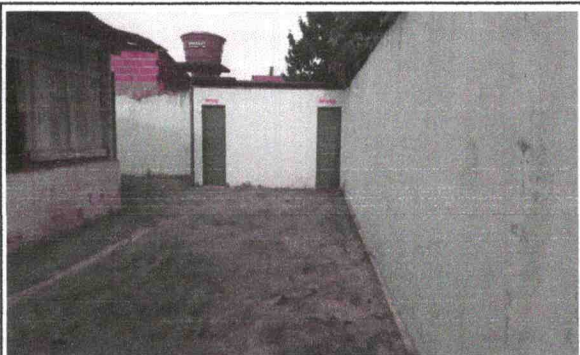
PARTE INTERNA - ENTRADA DOS BANHEIROS
