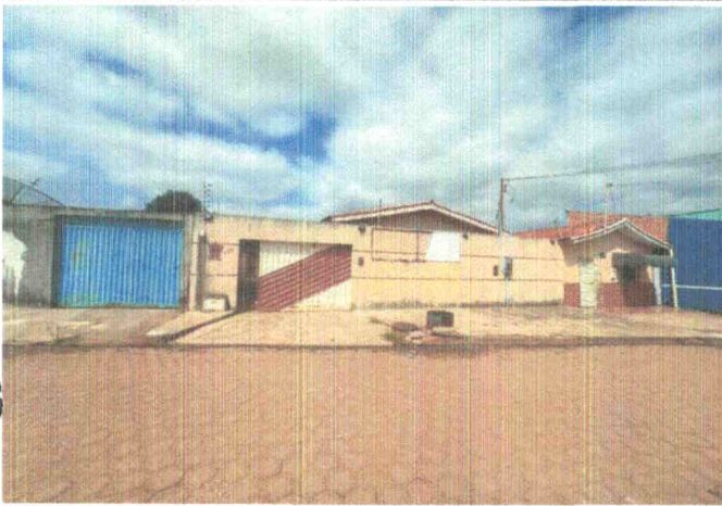
Vista do Logradouro à esquerda
